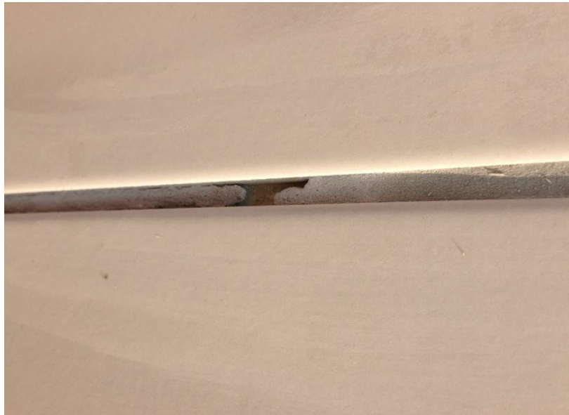
Valor < 0,3 Agua corrosiva
